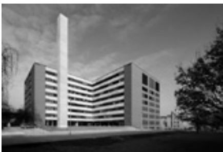
Novú budovu Fakulty architektúry ČVUT a Fakulty informačných technológií v Prahe navrhla Alena Šrámková. Slávnostne ju otvorili v marci 2011.
